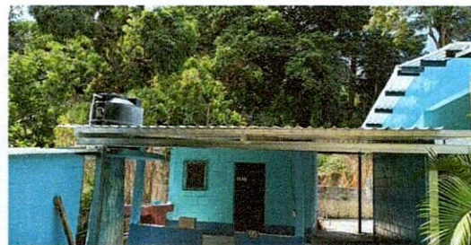
FOTO 2: Cambio de cubierta con lámina troquelada calibre 26, pintura, mejoramiento de puerta, balcón y cambio de ventanas
