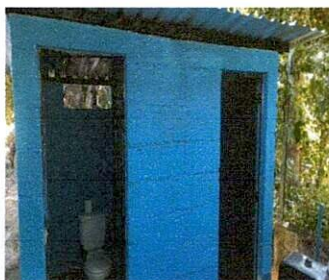
FOTO 3: Drenar el agua pluvial con tubería de cemento, entre módulos cocina y baño. Mejoramiento de baños, accesorios, pintura, puertas y cambio de una taza.
